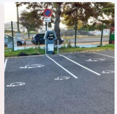
Ouverte à tous, cette borne permet le rechargement accéléré du véhicule estimé à 30 minutes pour 50 km, selon le modèle de véhicule. Deux types de prises sont présents.
